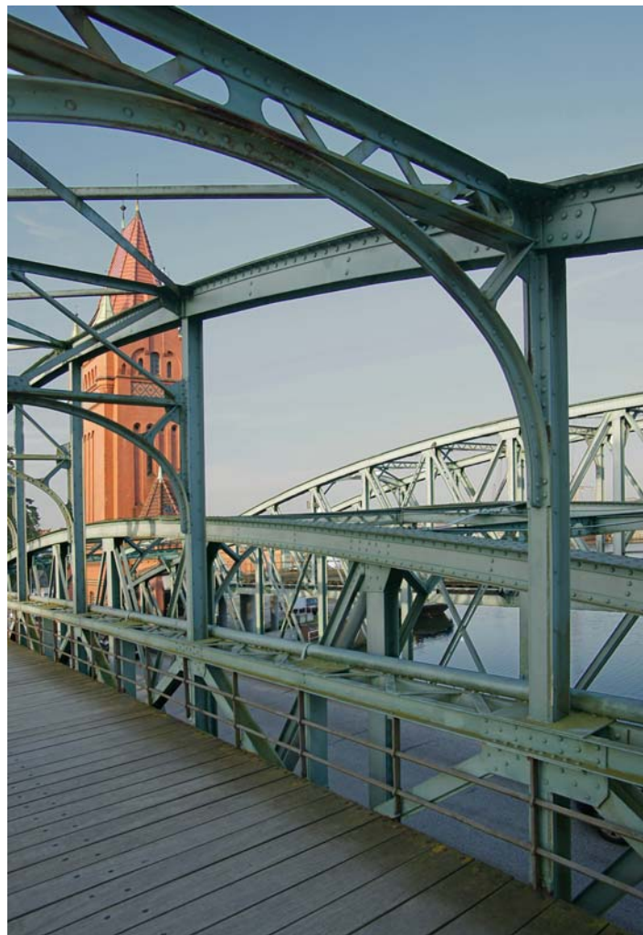
Lübecks Hubbrücken: Blick über die auch als feste Fußgängerquerung dienende Leitungsträgerbrücke auf die abgesenkte Straßen- und die hochgesetzte ehemalige Eisenbahnhubbrücke. Foto: Jörg Sellerbeck.
