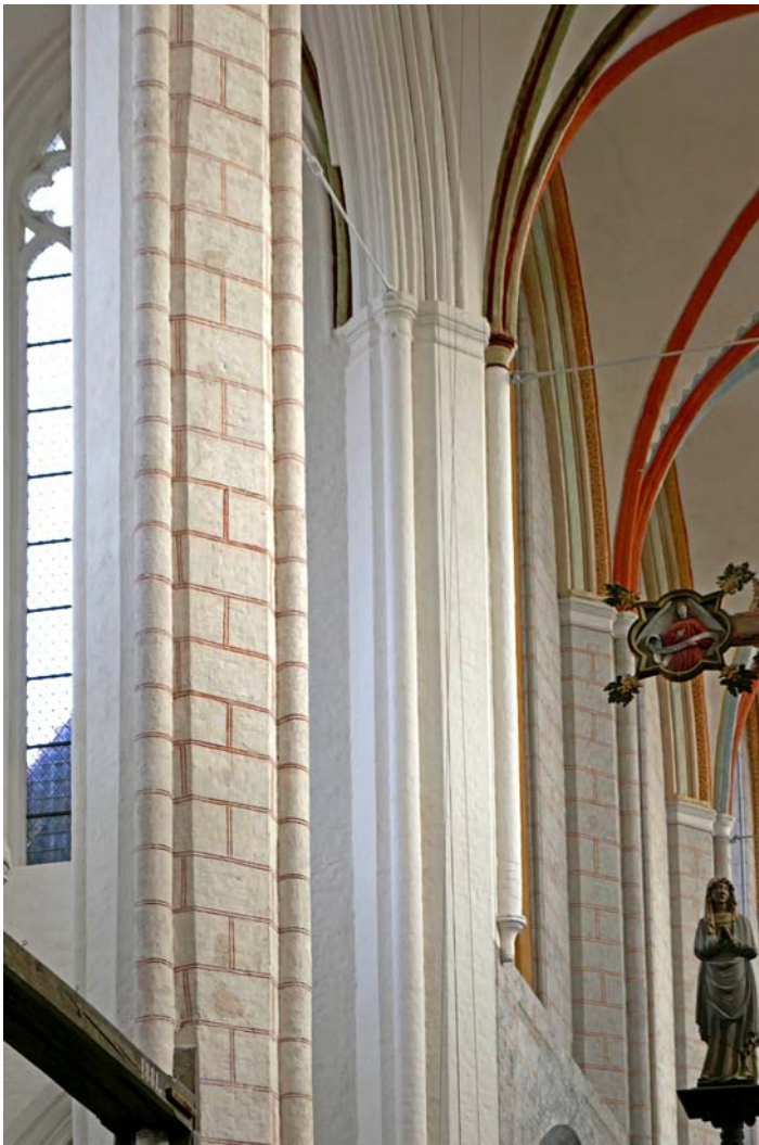
Die nördlichen Langhaus-Pfeiler bis zum Hochchor. Das Schlohweiß des Eckpfeilers als Demonstration heutiger Überzeugungen.
