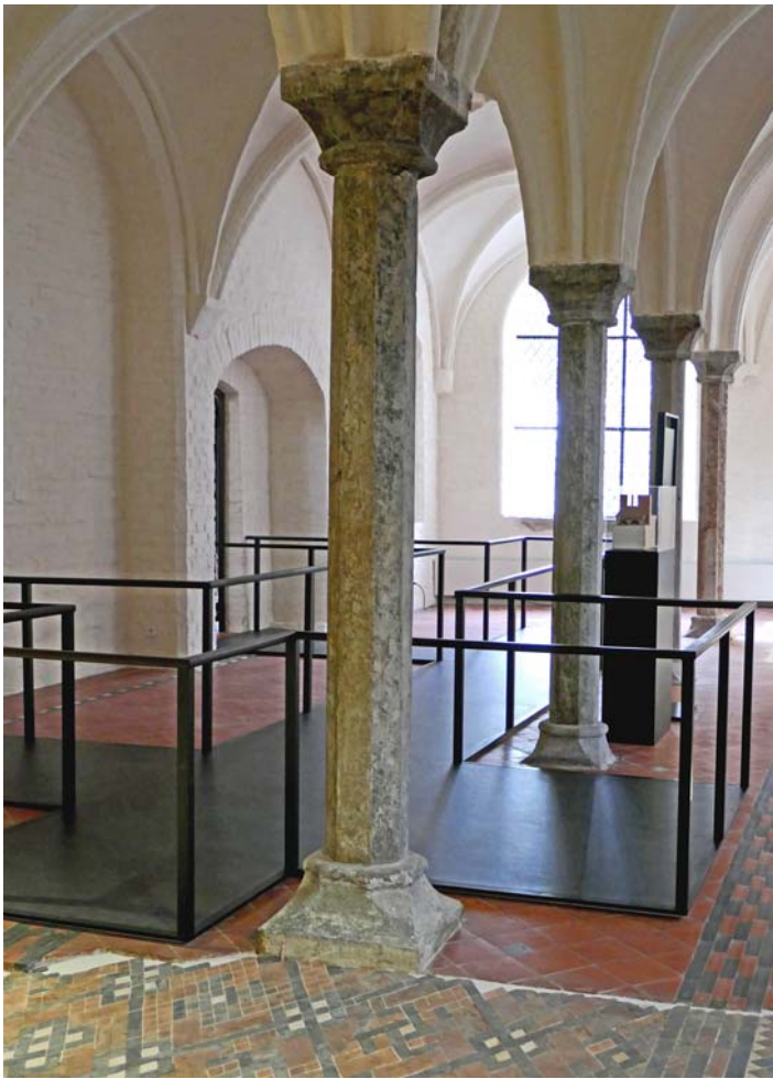
Erdgeschoss des Hospitals: begehbar per „eingefriedetem“ Korridor.
