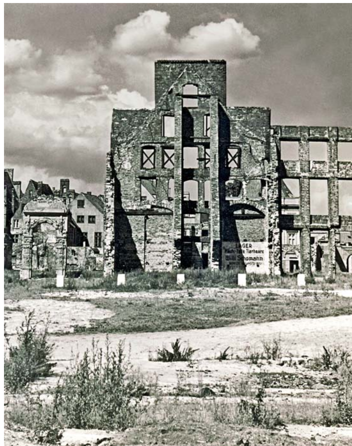
Fischstraße 19, gesicherte Rückseite der Fassade, gesehen aus der Braunstraße. Foto um 1950 von Theo M. Scheerer. Fischstraße 19 war die bedeutendste Fassade der hohen Gotik in Lübeck.
