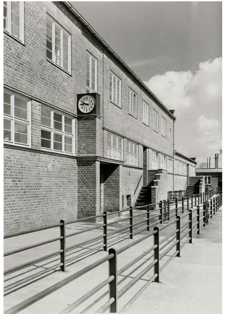
Oben: Das wie eine Schiffsbrücke gestaltete Verwaltungsgebäude mit seinen Zugängen zu den Räumen der Arbeiter (Waschkauen und Umkleiden), zur Betriebskantine (Treppenaufgang vorne), dem zentralen Treppenhaus mit dem geschossübergreifenden Fensterband und dem Uhrpylon.
