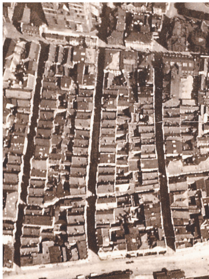
Bebauung zwischen Alfstraße (links), Braunstraße (rechts) und Untertrave (unten). Luftbild von 1919. An der oberen Bildkante: Marienkirche und Marienwerkhaus. Auch die einstigen freien Hofflächen sind fast überall verbaut.
