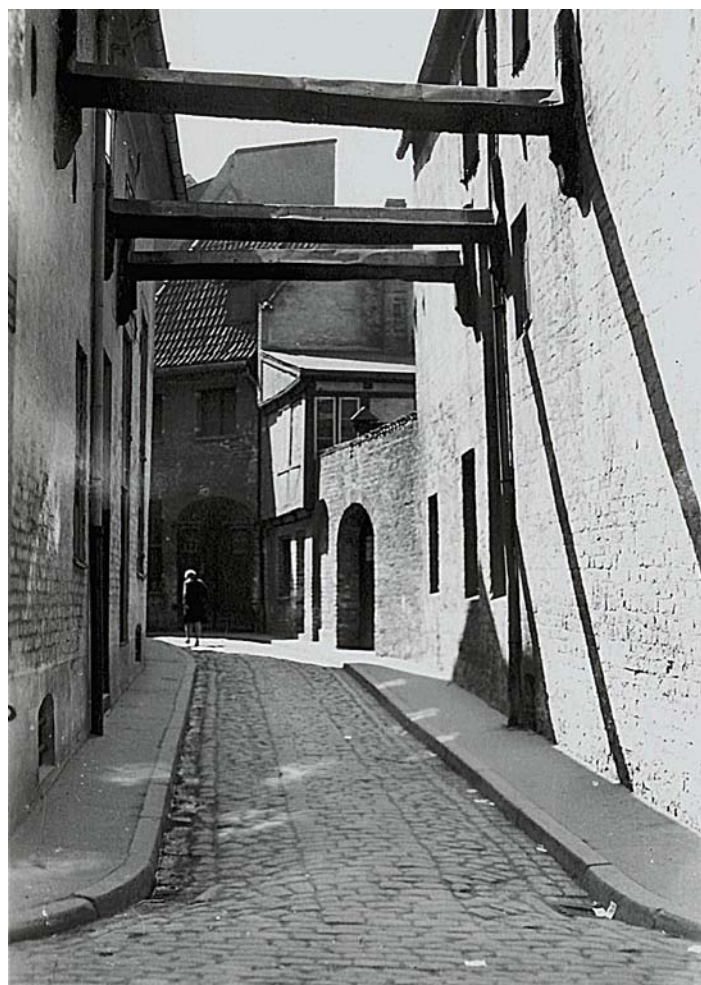
Oben Blick in die Krumme Querstraße Richtung Alfstraße, im Hintergrund der große Rückgiebel von Alfstraße 31 (Foto: Clara Gaedecke). Darunter: Blick in die Gegenrichtung (Foto: Walter Waßner). Der Knick in der schmalen Gasse erlaubte zumindest das Einfahren in das Grundstück Fischstraße 30 von der Rückseite aus, wie dies anhand des großen Tores festzumachen ist.
