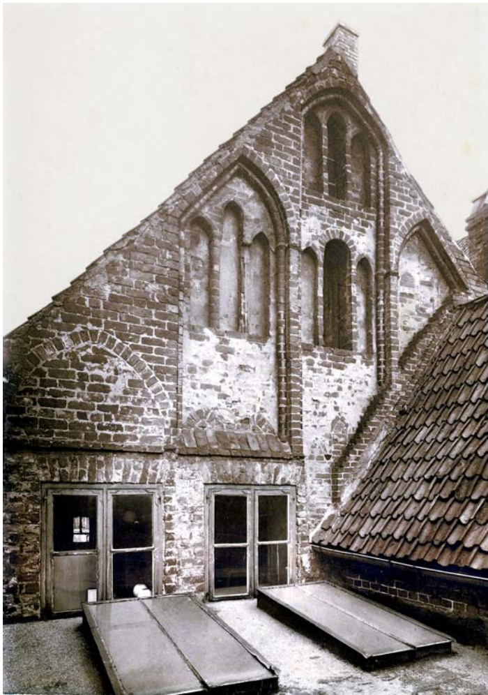
Rückgiebel von Königstraße 25 auf einem Foto von etwa 1900. Der klassizistische Umbau forderte Tribut von der einst wohl auch auf der Höhe des ersten Dachbodens und des Obergeschosses anzutreffenden vielfältigen Ausstattung. Mit Rücksicht auf die vorhandene Gestaltung wurden die Hochblenden wohl schon früher beschnitten bzw. verkürzt. Ihre Kanten sind durch eingelegte Rundstäbe betont. Im Bereich der Bogenansätze zitieren trapezförmig beschnittene Steine den Kämpfer bzw. Schaftring von Diensten und Dienstbündeln aus der Kirchenarchitektur. Auf dem historischen Foto gut erkennbar ist die diagonal versetzte Motivwiederholung der Drillingsgruppen.
